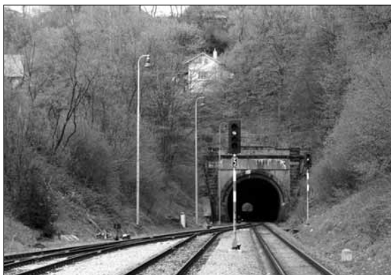
Severní ústí Sychrovského tunelu, 2013 (foto: Miloslav Rejha)
