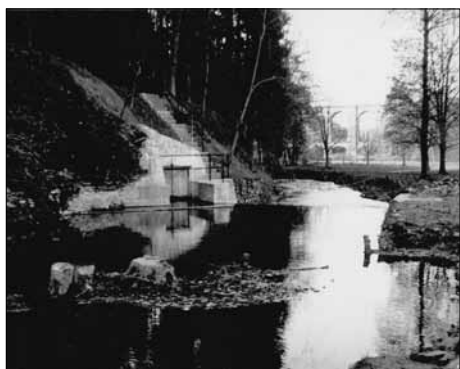
Fotografie pořízená při stavbě radimovického vodovodu (okolo roku 1941), hotový jez u pramenu, v pozadí viadukt (SOkA Liberec, fond Archiv obce Radimovice)
