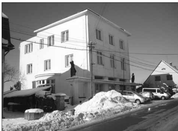
Vysocké čp. 308 vystavěné pro hospodářskou záložnu a sloužící nyní jako jedna z budov integrované střední školy. Foto: M. L. Jakl, r. 2015
