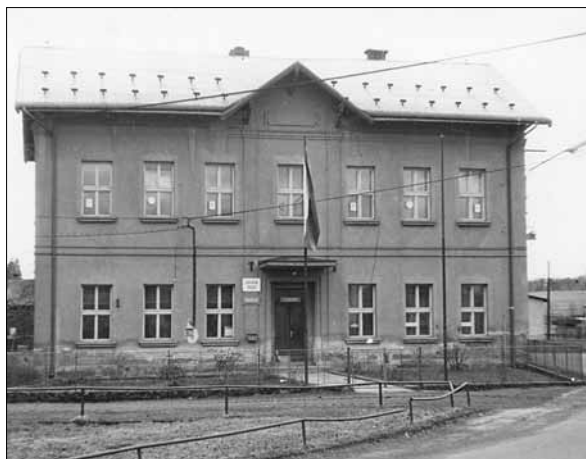
Budova školy v r. 1986
